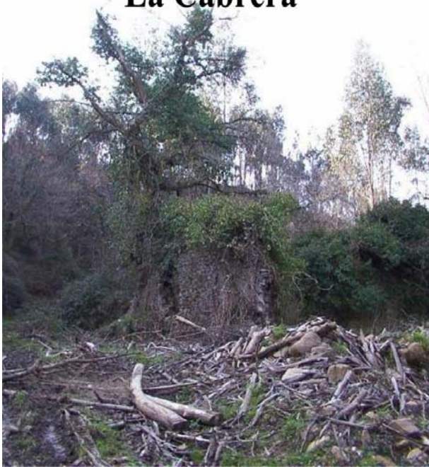
Ruinas de la ferrería de La Cabrera
