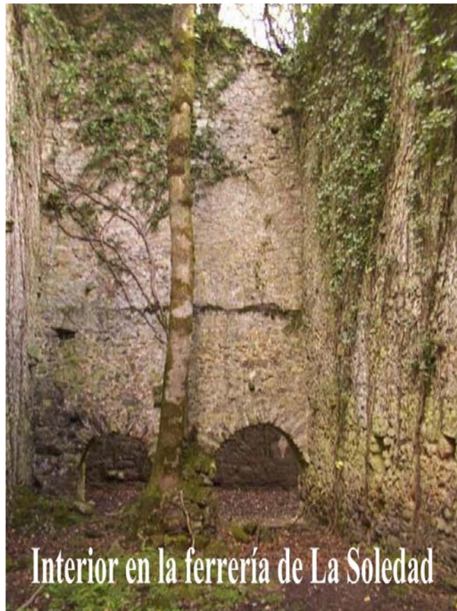
Túnel hidráulico/barquinera, ferrería de La Soledad
